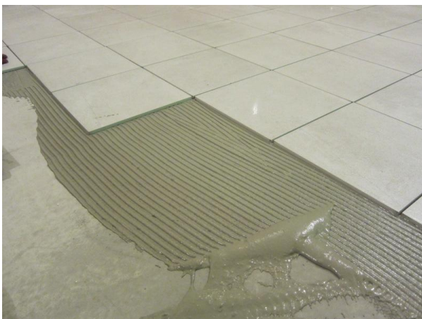
Valokuva 5. Keraamisen laattapäällysteen asennus
