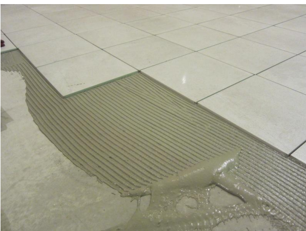
Valokuva 5. Keraamisen laattapäällysteen asennus
