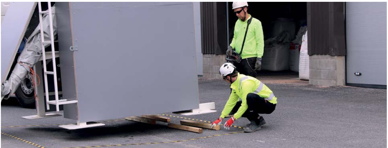
Työmaasiilo asennetaan kahden asteen kulmaan putkisekoittajan suuntaisesti.
