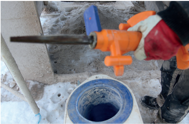
Märän pään sekoitinta ei saa rasvata - liitin on pidettävä kuivana.
