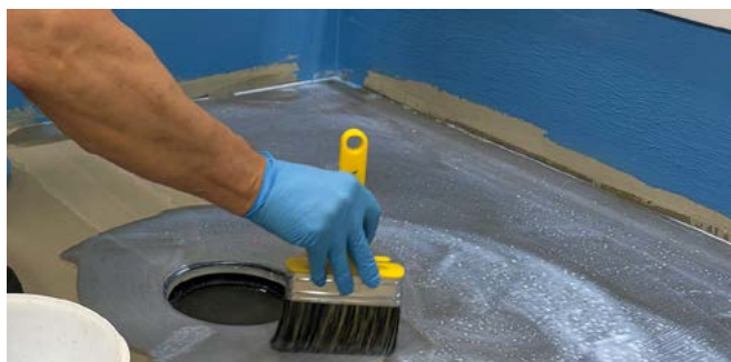
Nakkekrunt KP harjatakse õhukese ja ühtlase kihina, loike ei tohi jääda.
