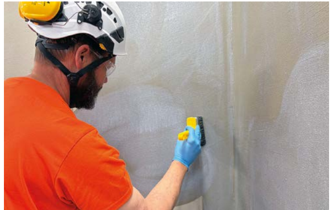
Seinad krunditakse nakkekrundiga KP
